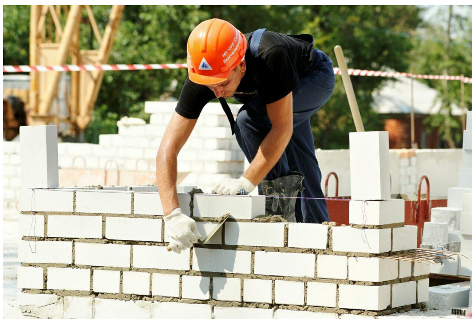
Рис. 11. Кирпичная кладка стены с перевязкой швов
