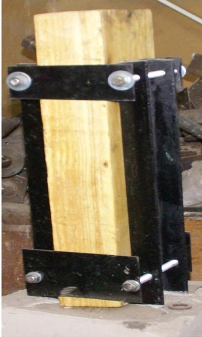
Защемление колонны в фундаменте с помощью пасынков-швеллеров
