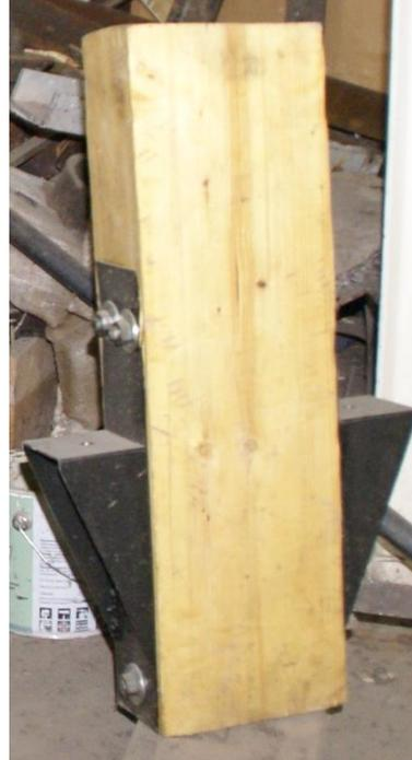
Защемление колонны в фундаменте с помощью сварных столиков
