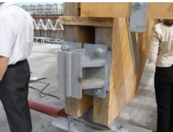
Конструкция опорного узла
