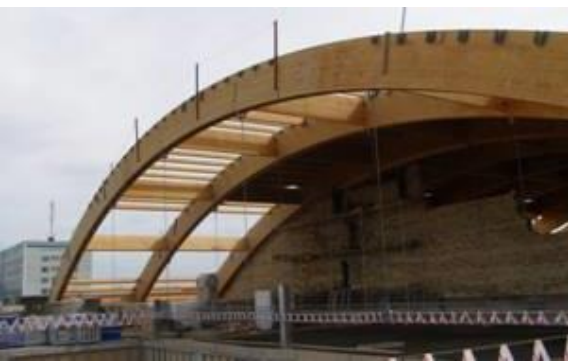
Внешний вид клеедеревянных арок покрытия пролетом 36 м, балок связи и прогонов
