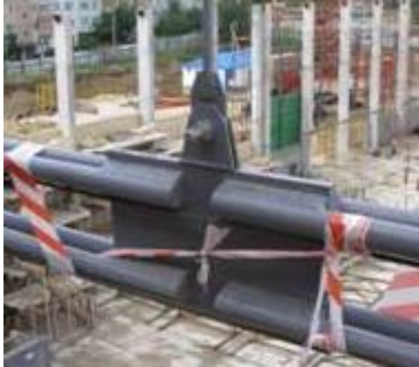
Стальная затяжка из 4 стержней и подвес
