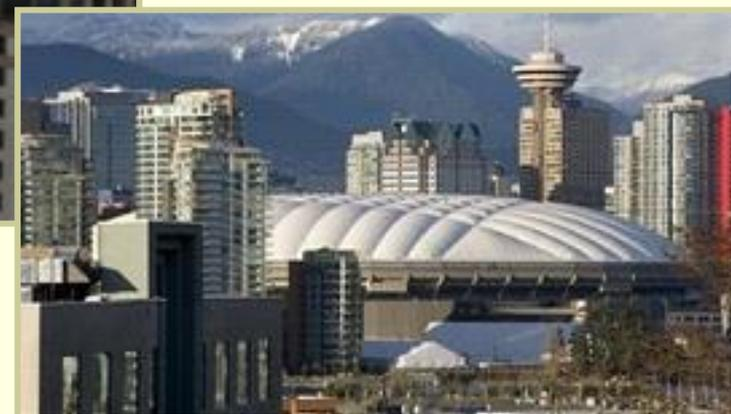
Периметр купола 760 м. Материал оболочки – стеклоткань покрытая тефлоном. Толщина ткани 0,85 мм.
