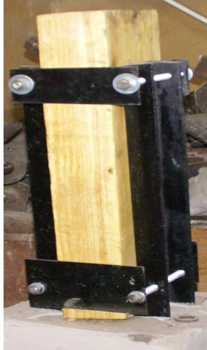
Зашемление колонны в фундаменте с помощью пасынков-швеллеров
