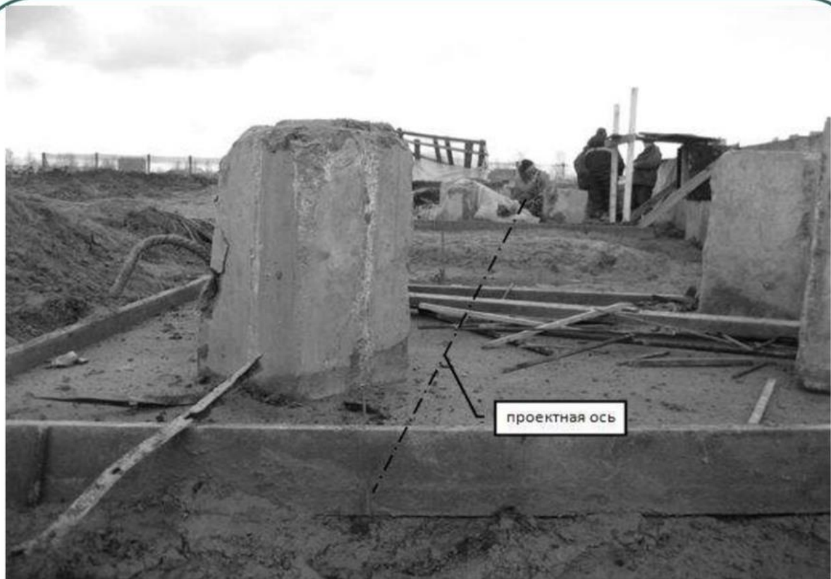
Фотография смещенного свайного куста относительно проектной оси
