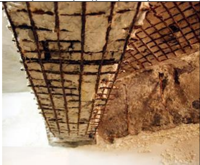
Поперечная арматура у опор
