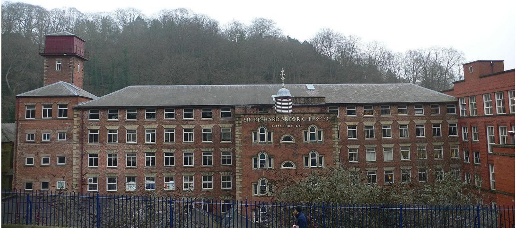
Ранние фабрики были узкими и низкими, располагали маленькими станками, приводимыми в действие водяным колесом. Основным освещением был дневной свет, а высота до потолка была 6-8 футов (2 — 2.5 метра). Фабрика «Мэссон» в Дербишире является хорошим примером ранней хлопкопрядильной фабрики. Фабрики строили инженеры, строители и литейщики, такие заводы Аркрайтового типа были около 3 метров шириной.
