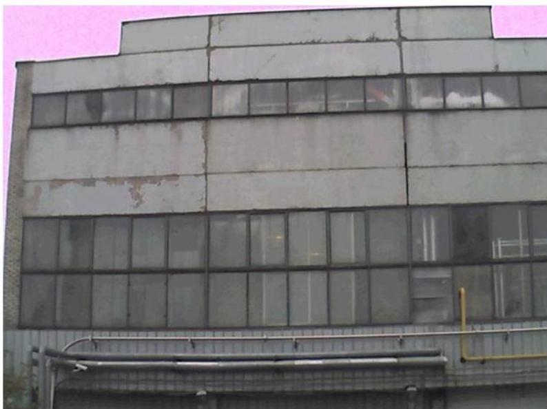
Рис. 2. Стена промышленного здания с навесными железобетонными панелями
