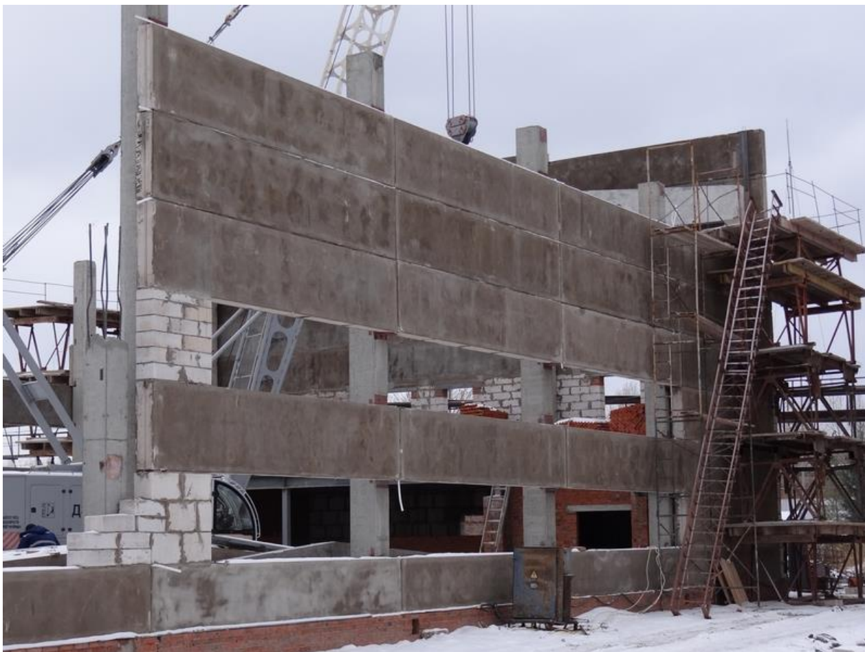
Рис. 13. Легкобетонные панели стен
