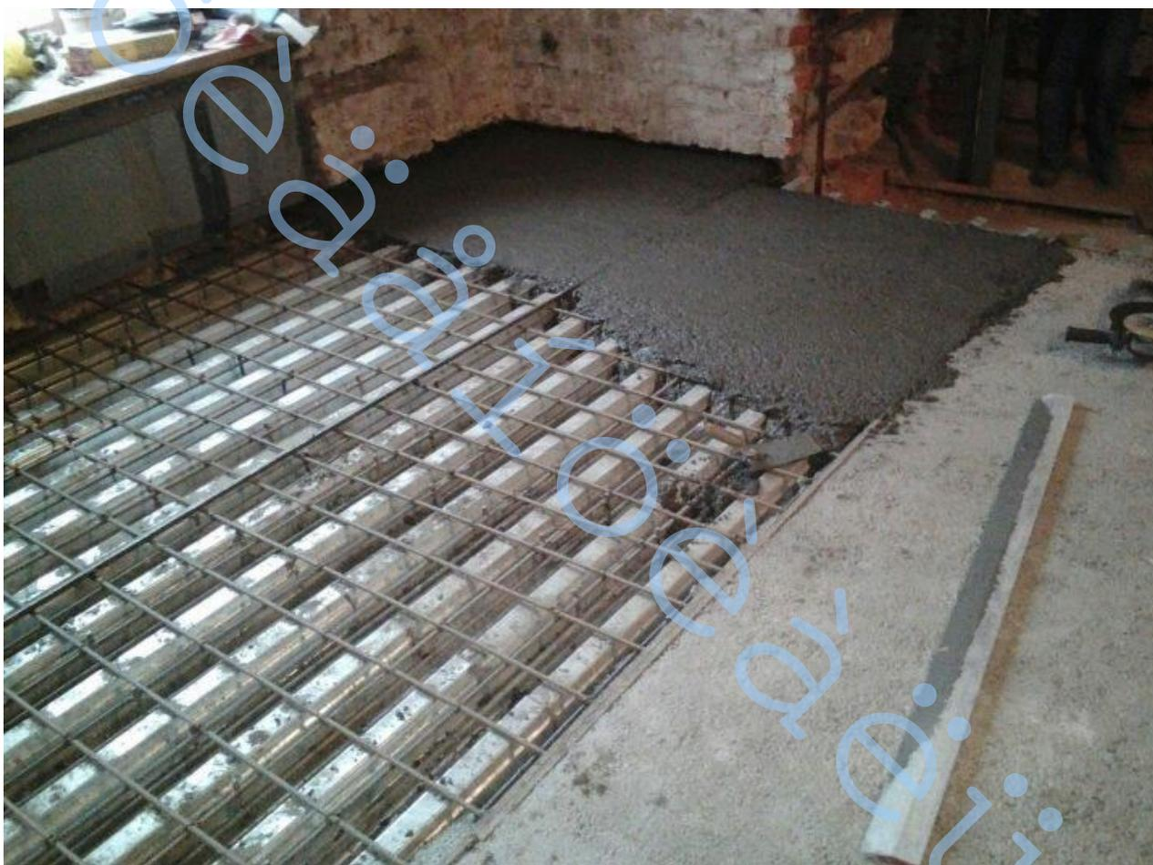
Рис. 13. Устройство монолитного участка перекрытия по профнастилу
